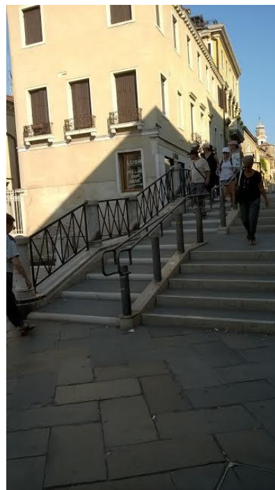
Ponte San Felice Strada Nuova
